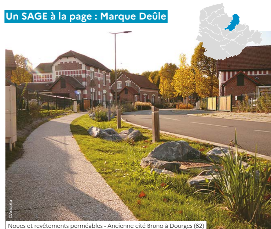
Noues et revêtements perméables - Ancienne cité Bruno à Dourges (62)
